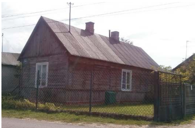
Dom drewniany parterowy z widocznym niskim, niezaadaptowanym strychem i starymi, białymi oknami.
