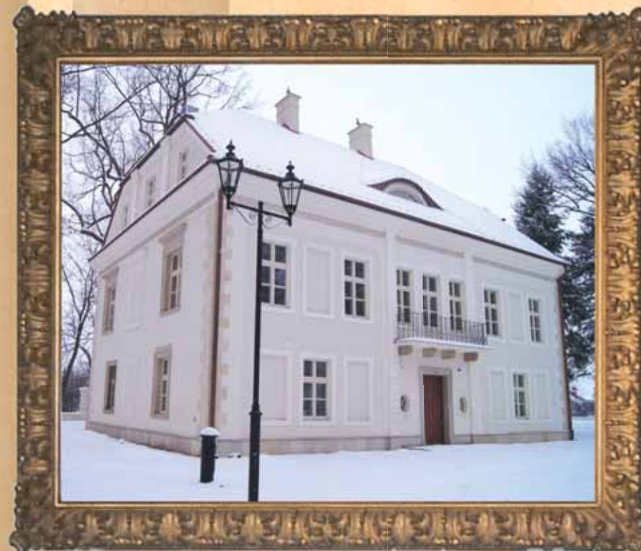
▲ Pałac - stan po remoncie 2013 r.
