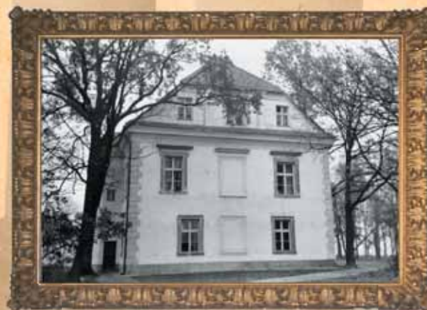
▲ Elewacja południowa - stan 1965 r.
