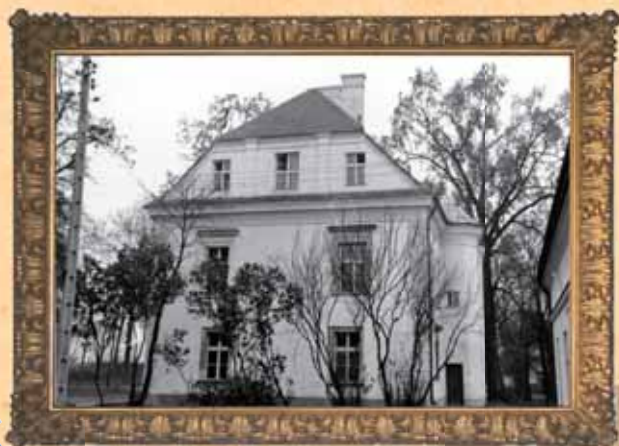
▲ Elewacja północna - stan 1965 r.
