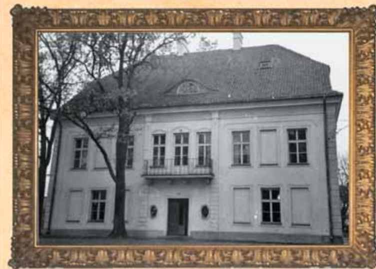
▲ Elewacja wschodnia - frontowa - stan 1965 r.
